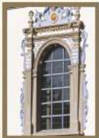
Obramienie okna w kaplicy Górnkich Framing of the window in the Górnki chapel
